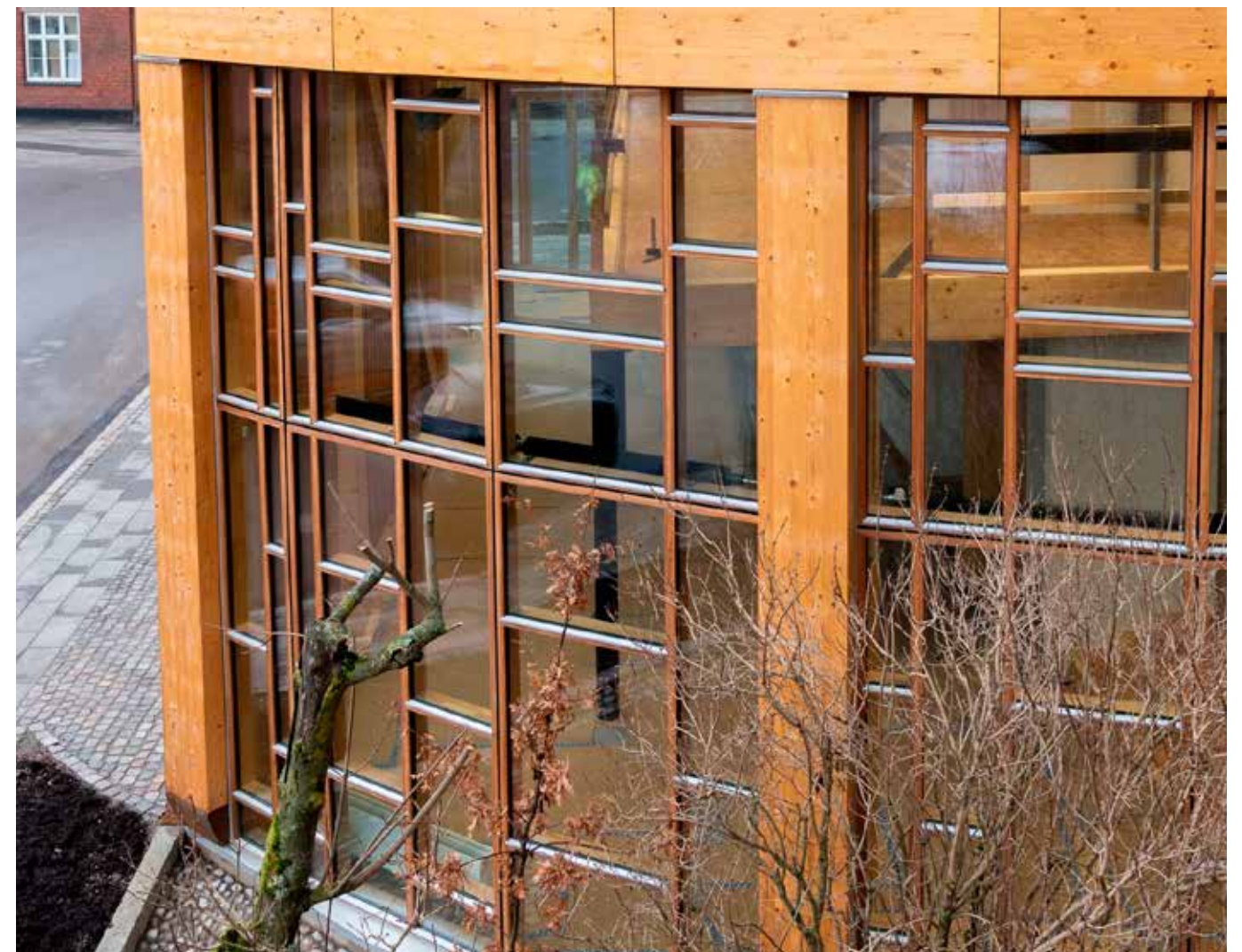
Viddø Glass Window System fra A:GAIN. Foto: A:GAIN
