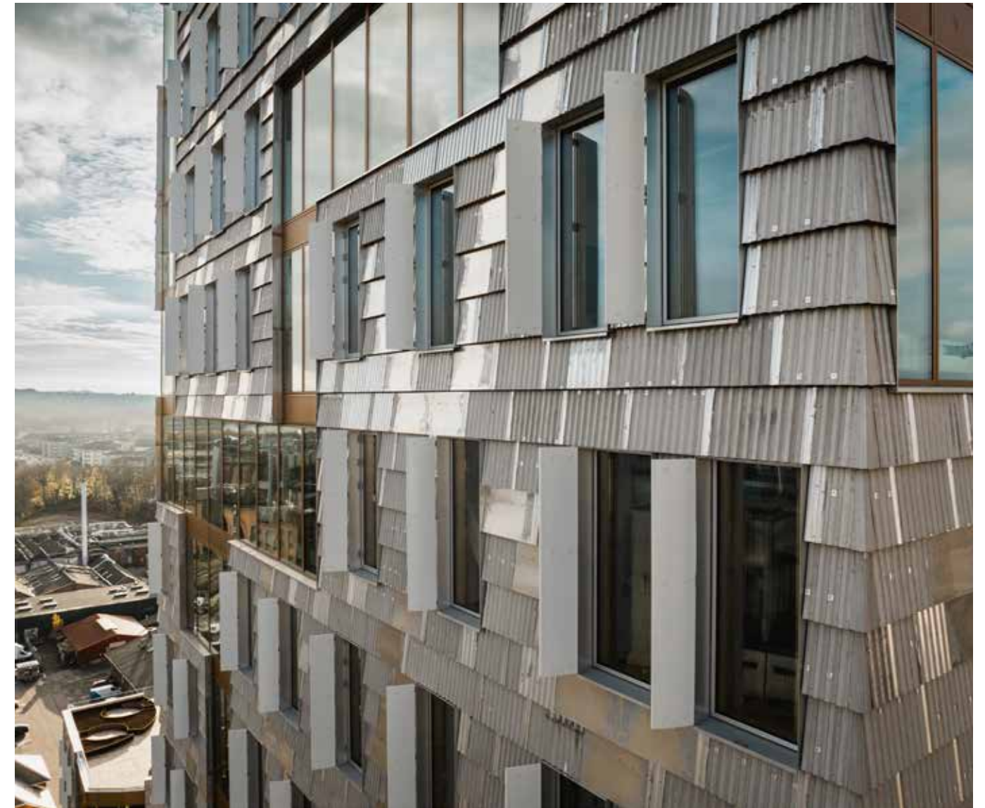
Solafskærmning på facaden. Foto: Anders Nymann Wejse
